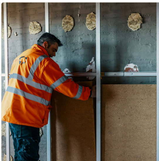
La posa di un pannello isolante FIBOO in cantiere.
